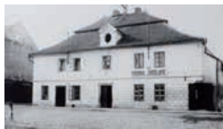
Dům č. p. 179 na „Velkém náměstí“ z poloviny 18. století, v němž byl umístěn od roku 1901 poštovní úřad.
