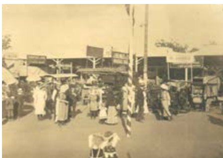
Částečně kryté strojího oddělení na Bucharově zahradě, 18. 8. 1911
