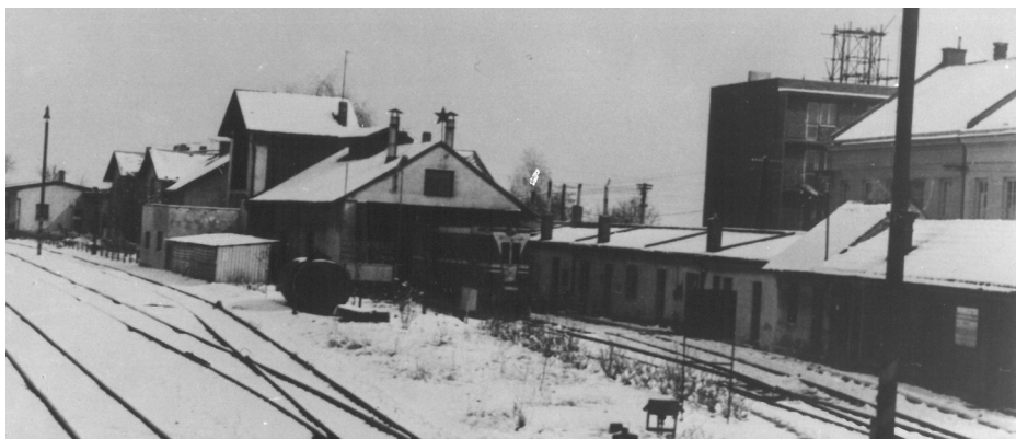
Nádražní depo, stavba bytovky, 1966
