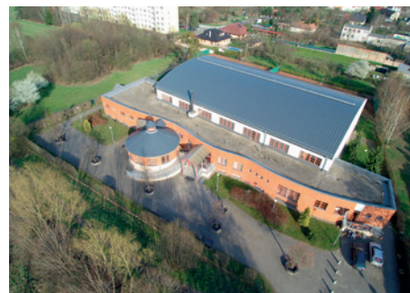
Letecký pohled na halu
