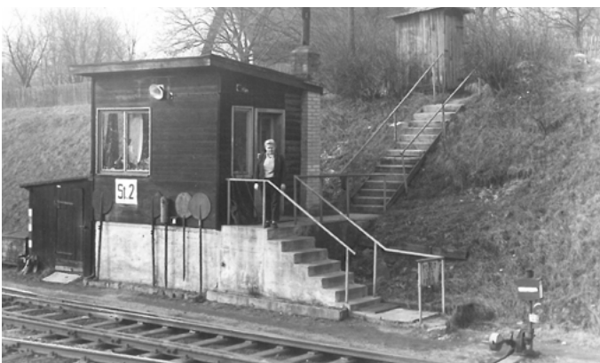
Stavědlo č. 2 na přeloučském zhlaví
