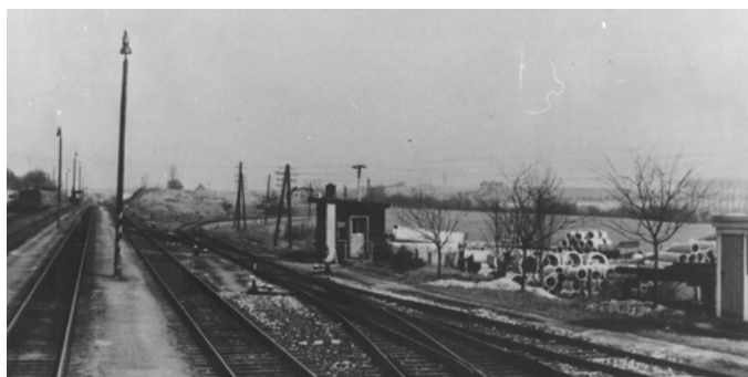
Výhybkářské stanoviště na chrudimském zhlaví
