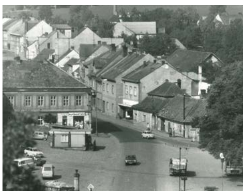
Pohled na záp. stranu náměstí na konci 70. let 20. století s rohovým patrovým domem č. p. 191 (papírnictvím)
