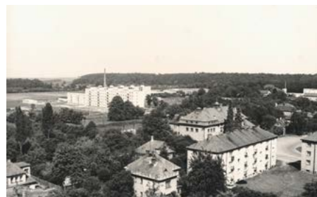
Pohled na sídlště ze střechy bývalého hotelu Heřman
