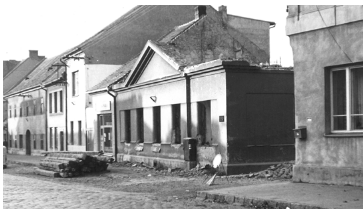
Bourání Brachtlova domu, 1972
