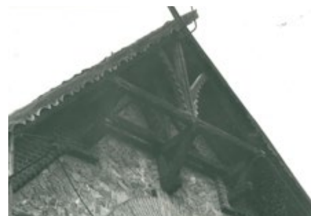
Detail štítu elektrárny
