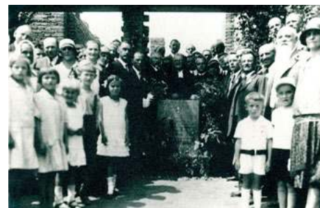
Pokládání základního kamene, 21. 7. 1929
