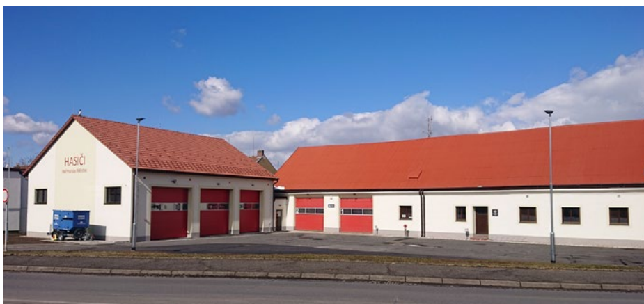
Co se povedlo – přístavba hasičské zbrojnice
