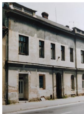
Löwitaův dům před rekonstrukcí, 1990
