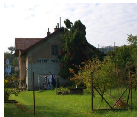
Bývalá železniční stanice Vápenný Podol v září 2010
