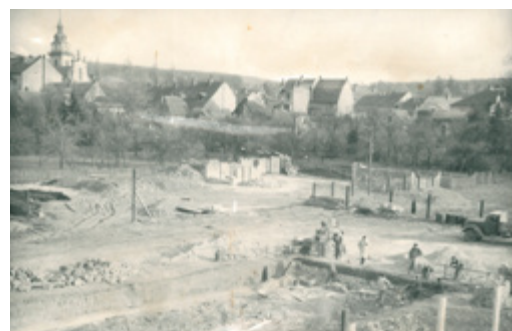
Počátek výstavby bytového domu svépomocí, 1959
