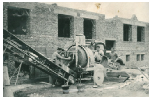
Průběh stavby domů svépomocí 1960
