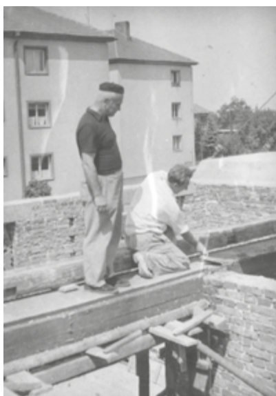
Stavební dozor při výstavbě, v pozadí již stojí vojenské bytovky, 1960
