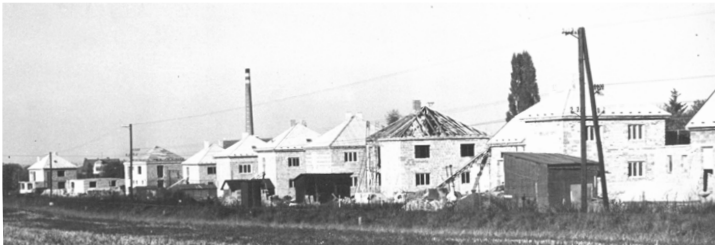
Stavba nové ulice podél trati
