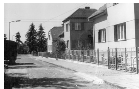
Pohled do ulice Veselé, 1976
