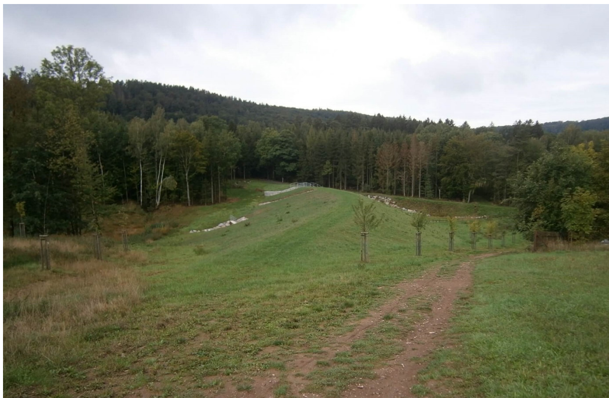
Obr. Sypaná zemní hráz suché nádrže (transformace Q_{100} na Q_{10} ) pohled v úrovni koruny (šířka 4,0 m)
