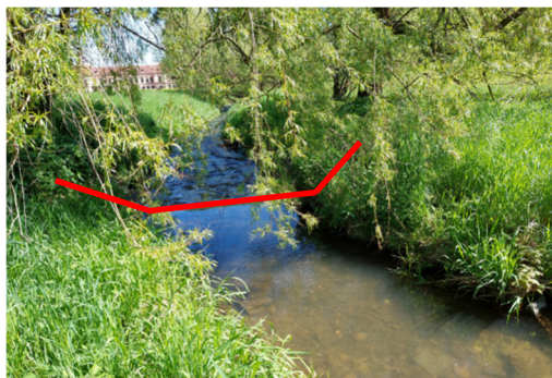
Obr. Stávající betonový práh
