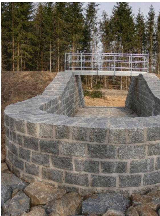
Obr. Bezpečnostní přeliv typu kašna
