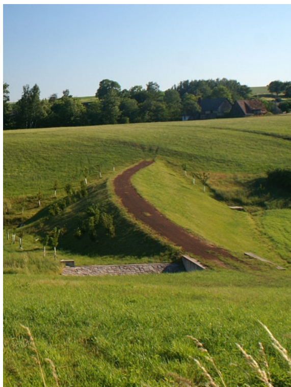
Obr. Hráz s bočním bezpečnostním přelivem
