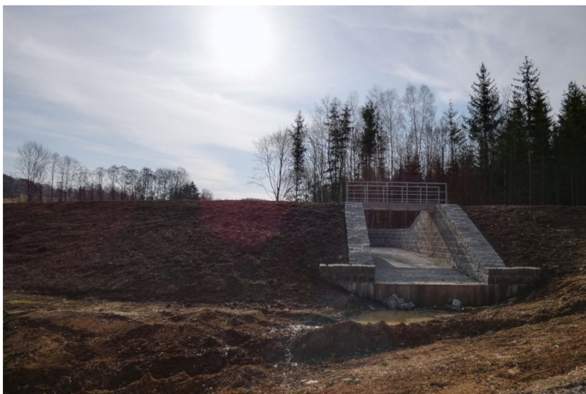
Obr. Vzdušní líc hráze a vyústění bezpečnostního přelivu (Suchá nádrž na Počáteckém potoce)
