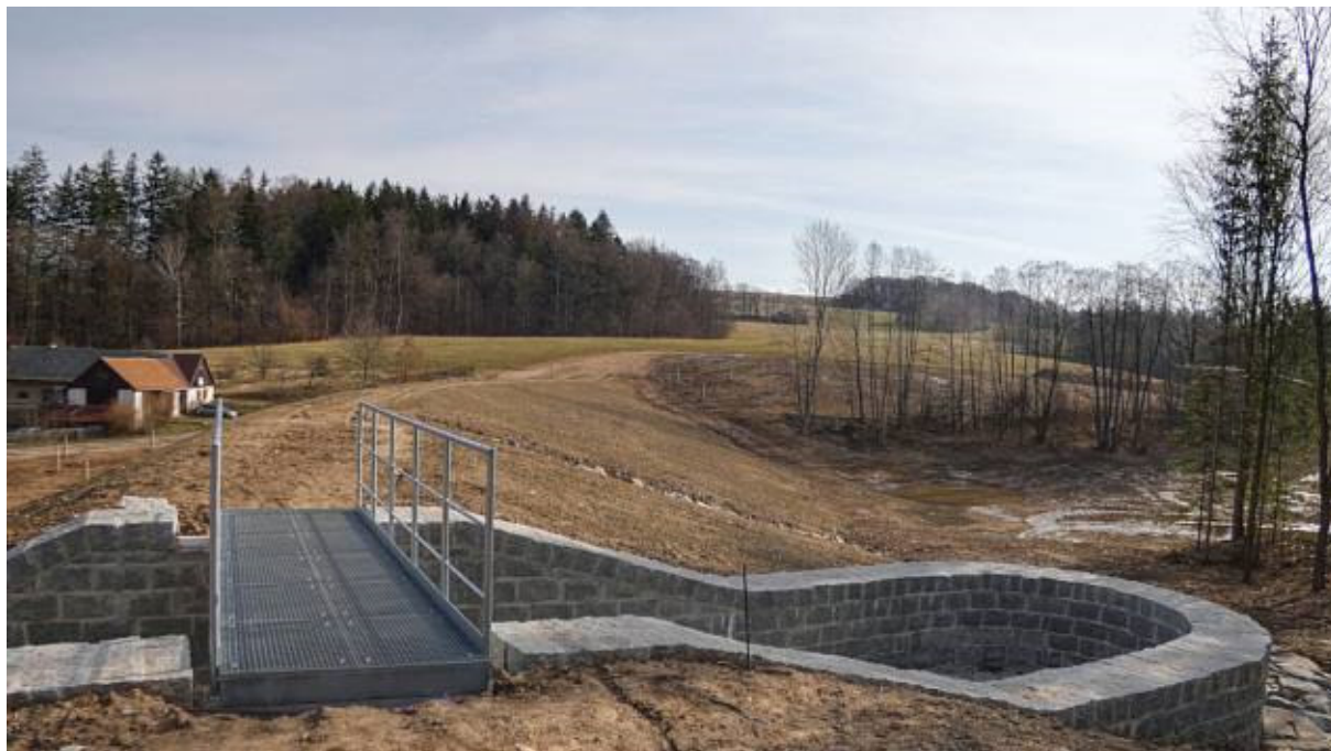
Obr. Hráz (výška 8,2 m, délka 158 m) s kašnovým bezpečnostním přelivem (Suchá nádrž na Počáteckém potoce)
