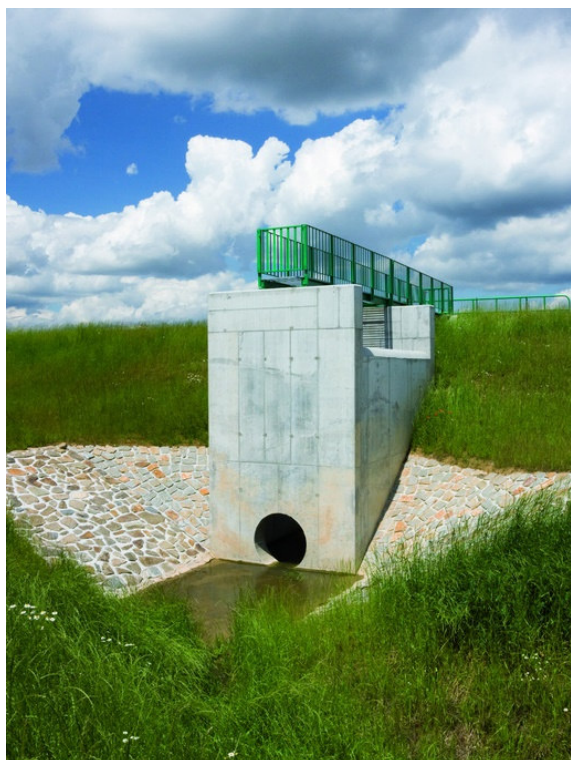
Obr. Sdružený funkční objekt s trubní výpustí
