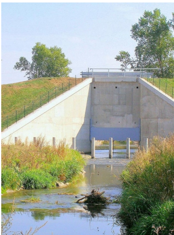
Obr. Plně migračně průchodná spodní výpust
