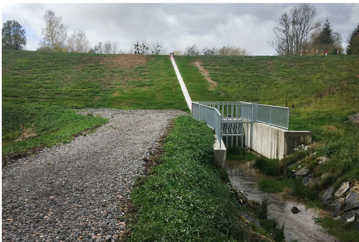
Obr. Návodní líc hráze výšky 9,4 m a délky 75 m (Suchá nádrž Člupek - Némčice)
